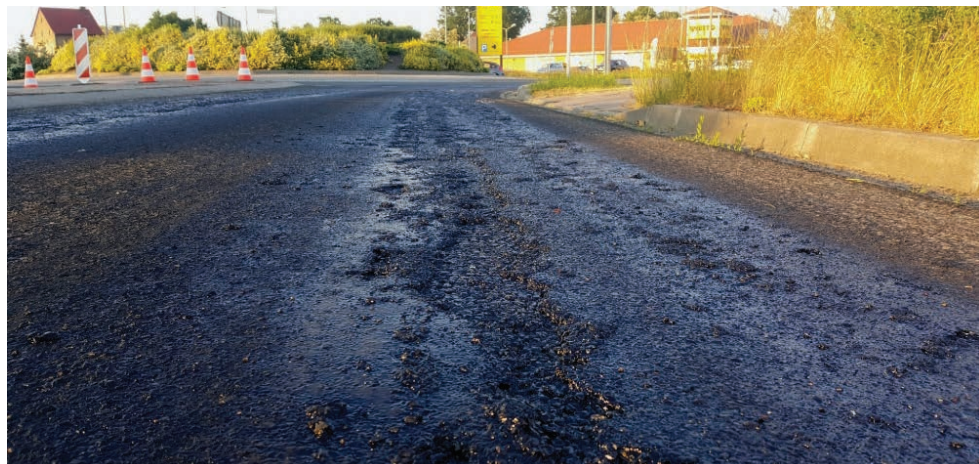
Rys. 22. Asfalt stopiony od temperatury [18]
